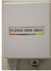
Figure 6 : FTTE passif PM - exemple de PTO
